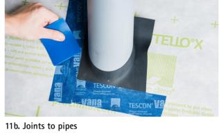
Place a ROFLEX pipe grommet over the pipe and stick to the membrane using TESCON VANA.  $\label{eq:constraint} % \begin{subarray}{ll} \end{subarray} % \begin{subarray}{ll} \end{subarr$
